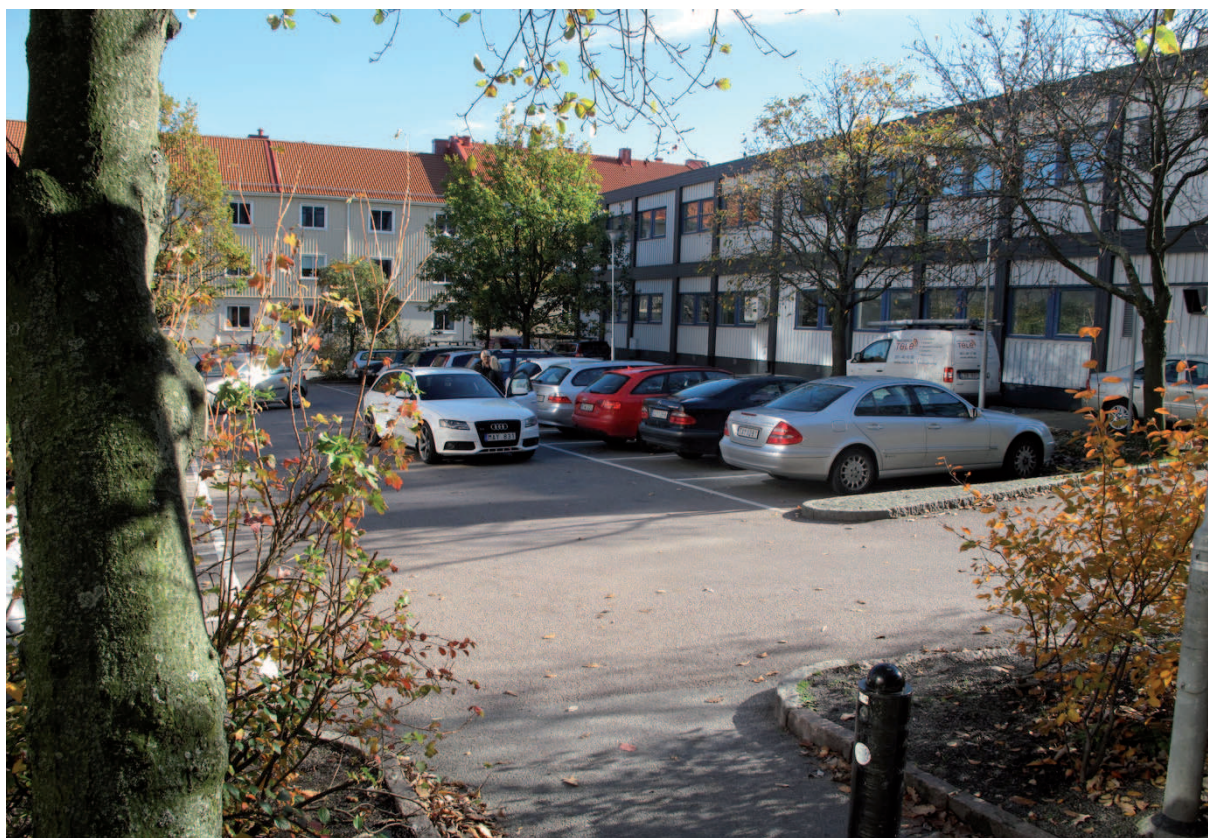
Sjukhusplatsen med parkering och dialysbarackerna. Barackerna skall tas bort innan årsskiftet 2012-2013
