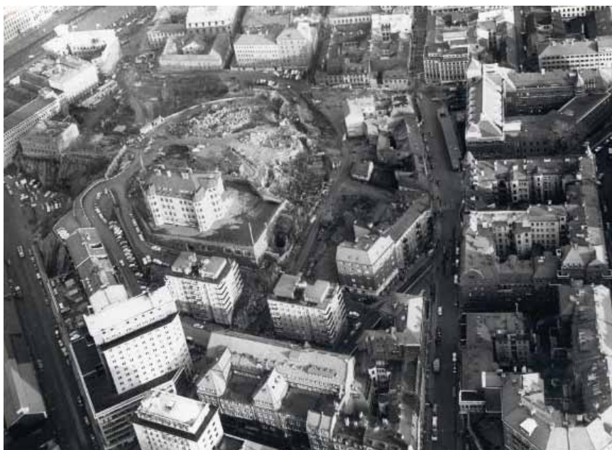
Punktsanering på Stora Otterbällan. I bildens centrala parti rivningsområdet där Södra Liden m.fl. gator legat. Foto från 1962, fotograf okänd
