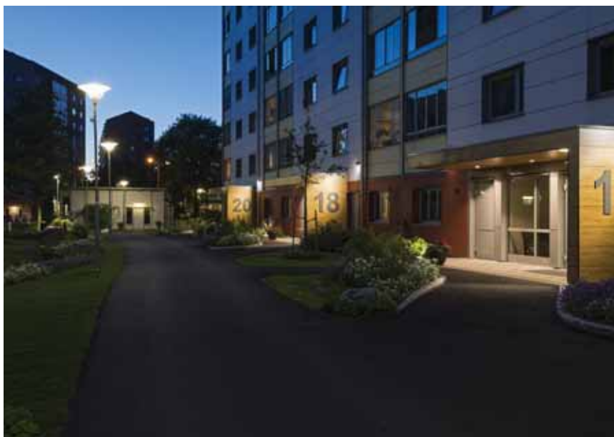
Upprustat bostadsområde i Brunnsbo. Fasaderna har klätts in, fönstren bytts och nya entrépartier har skapats. Gårdarna har helt gjorts om. Foto: Kajsa Sperling
