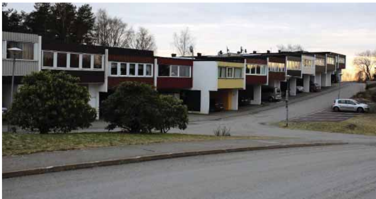
Del av radhuset sett från Västerslänt. Individuella färgval och utbytta fönster har med tiden gett området en brokig karaktär.
