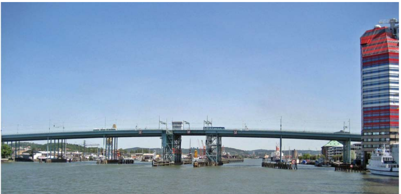
Befintlig bro sedd från väster Existing bridge as seen from the west
