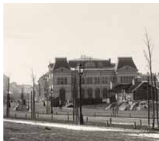
Den nyanlagda Vasagatan som leder från Heden till Haga, sedd från öster vid Flygarn's Haga. Stenhuset med rundbågade fönster är den gamla Betlehemskyrkan. 1880-talets mitt. Foto: Aron Jonason. GSM
