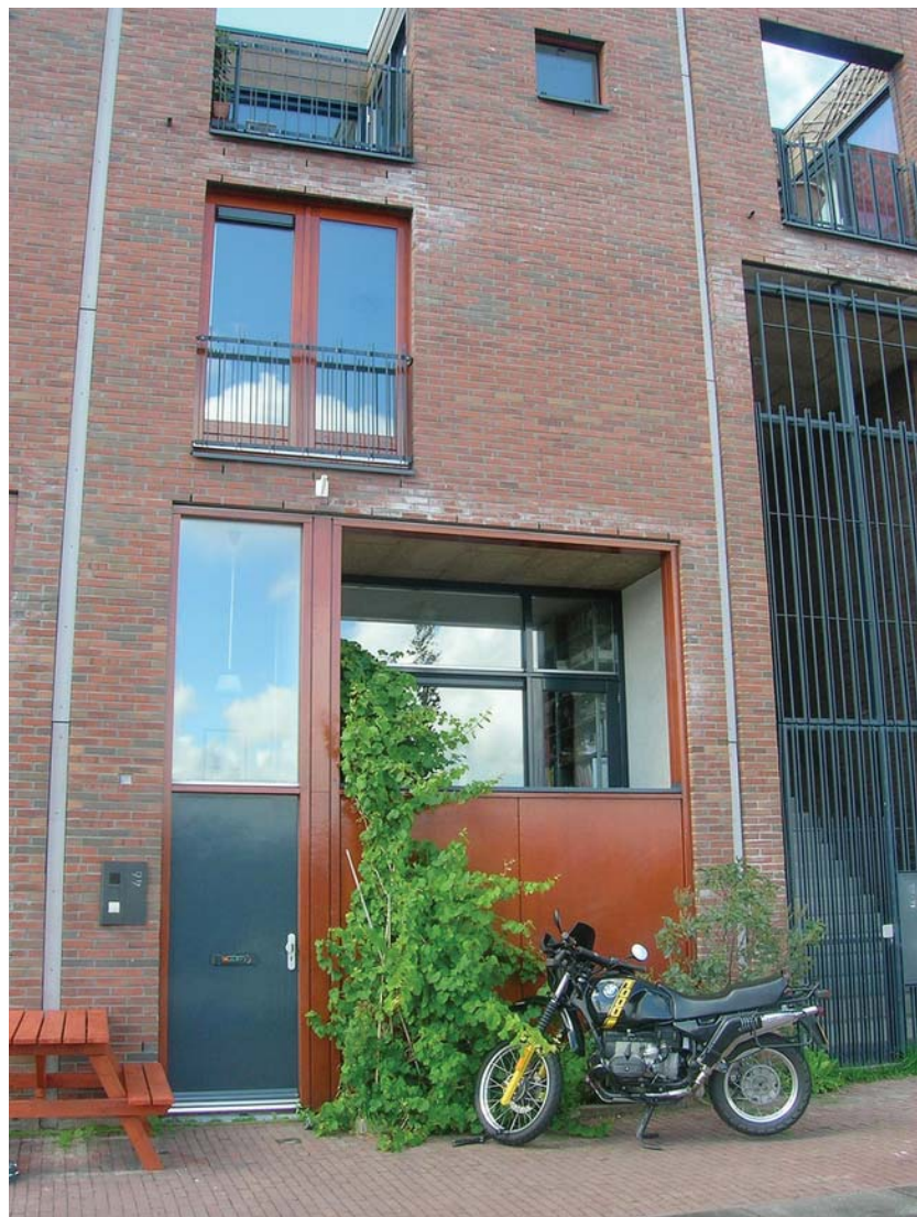
Radhus i bv till kvarteret, med egen entré utifrån. Bidrar till en levande gatumiljö.
