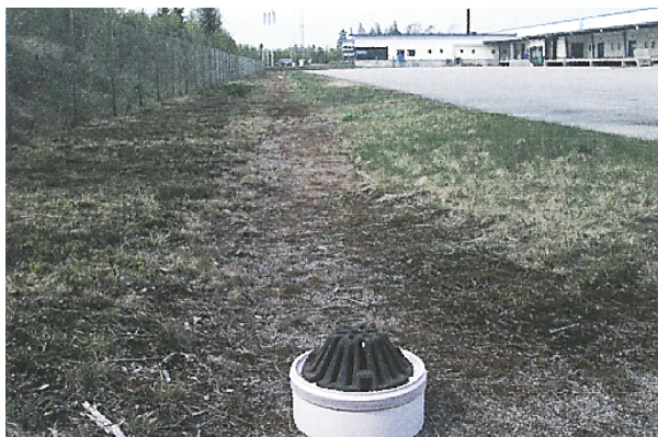
Figur 5: Dagvattenintag med viss uppdamningsnivå
