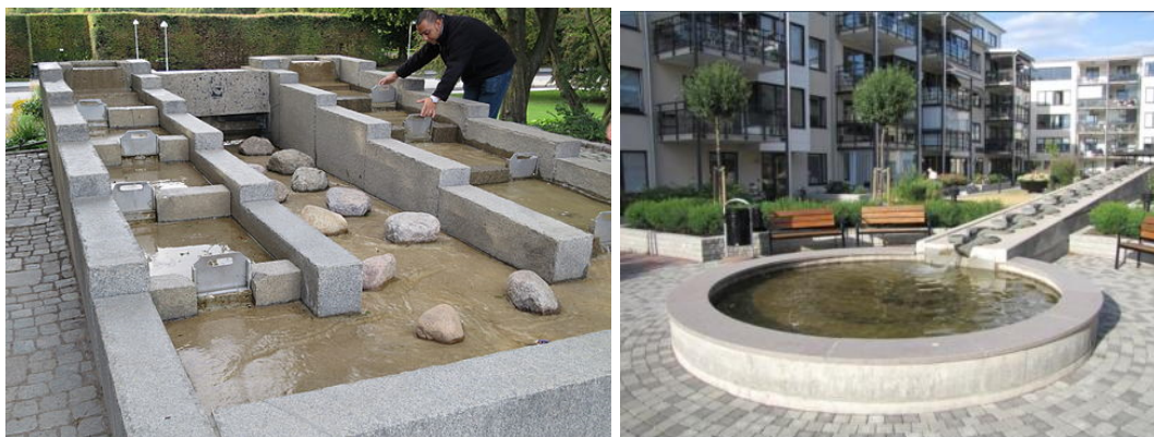
Figur 10: Exempel på dagvattenelement (th: Wikimedia Commons, Jorchr. tv: flowforms.se)
