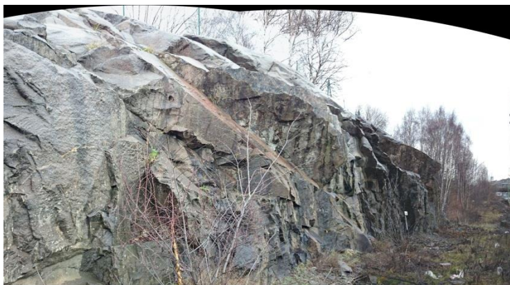
Figur 6.22 Medelbrant slag som lutar ut mot järnvägen.
