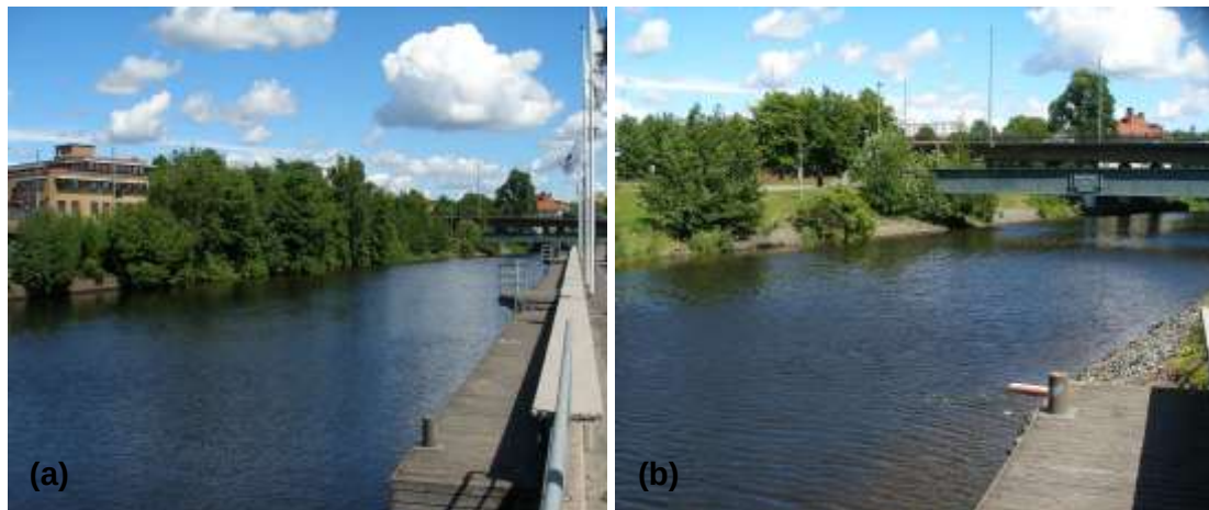
Figur 10 (a) Stödmurar och kajkonstruktioner (b) Erosionsskydd i form av sprängsten.
