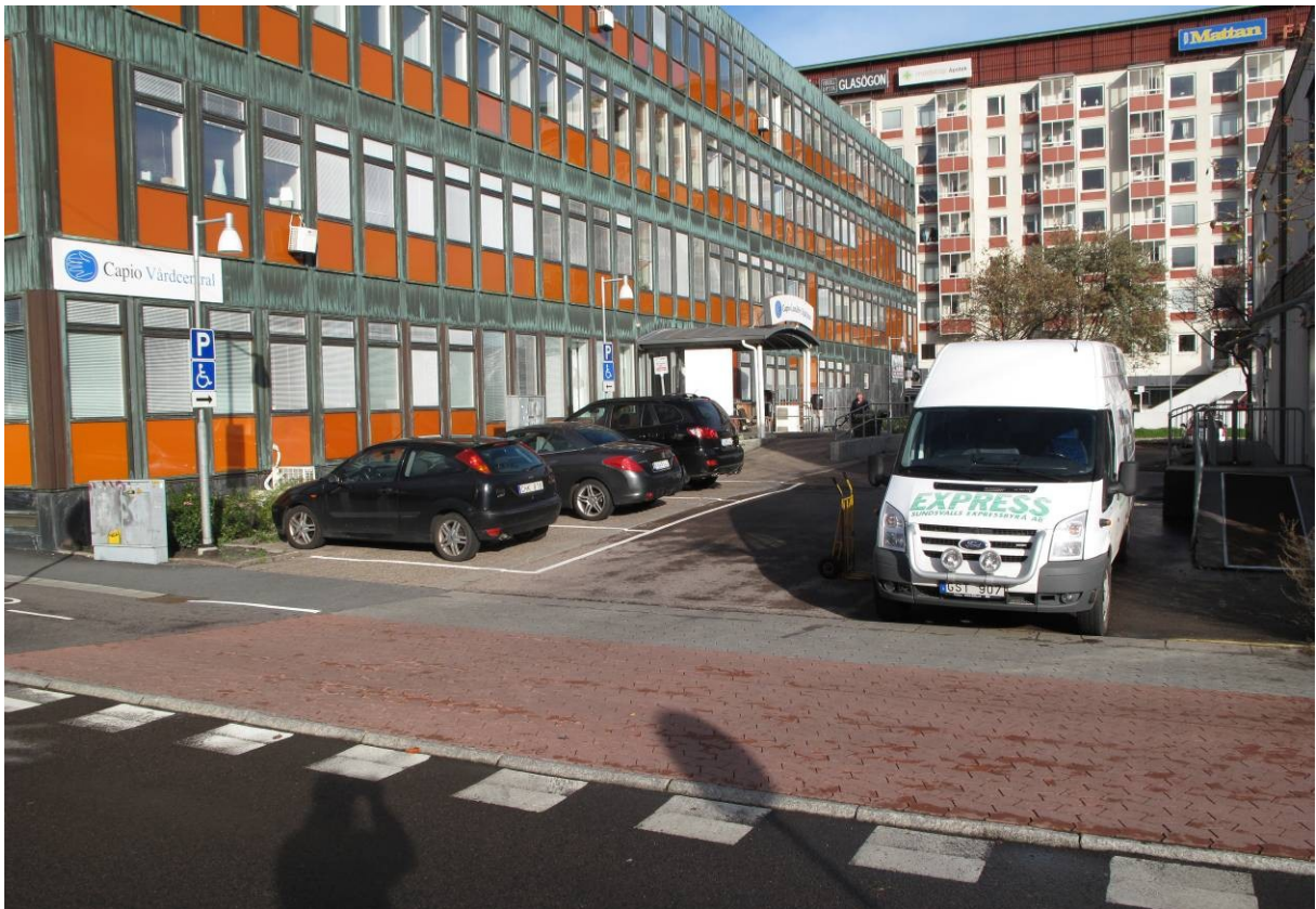
Sjukhusentrén. Saknas riktig ambulansangöring.
