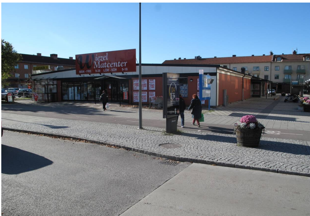
Matmarknaden, (gamla biblioteket) måste rivas för att ge plats för nya byggnader
