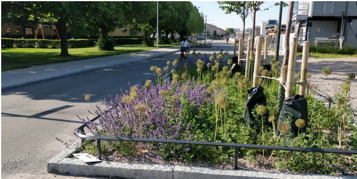
Figur 26. Biofilter Östra Sala backe i Uppsala.
