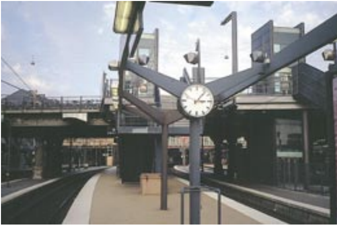
Bangårdsviadukten i Köpenhamn; hiss och trappa från plattformen, cykelparkering på bron.
