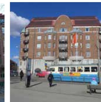
Heden 31:6 & 31:8 Uppförd: 1900-1910 Skydd: Rivningsförbud och skydds- och varsamhetsbestämmelser i detaljplan.
