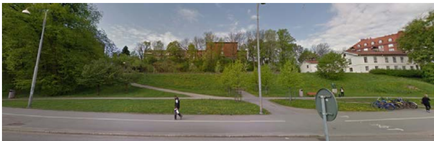
Foto 1. Släntområdet, fotoriktning från öster åt väster (Foto google maps)
