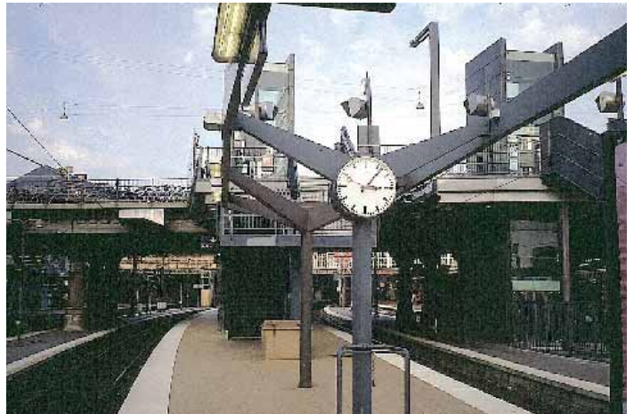
Bangårdsviadukten i Köpenhamn; hiss och trappa från plattformen, cykelparkering på bron.
