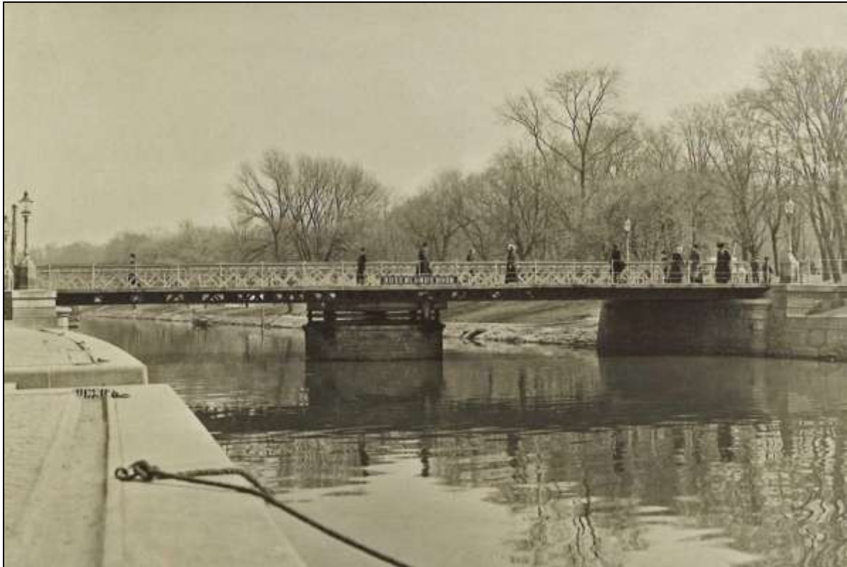
Första Rosenlundsbron fotograferad nästan rakt från sidan från Fisktorget. Med tanke på klämodet kan bilden vara tagen omkring 1900. Brons gallerverksbalkar syns tydligt liksom belysningsarmaturerna och murverkens översta, vulstformade skift. Bild i Regionarkivet.
