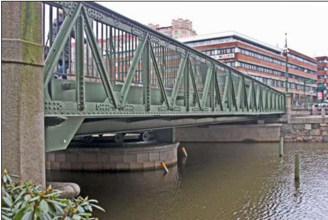
Tredje Rosenlundsbron från sydöstra landfästet. Foto BS 2014
