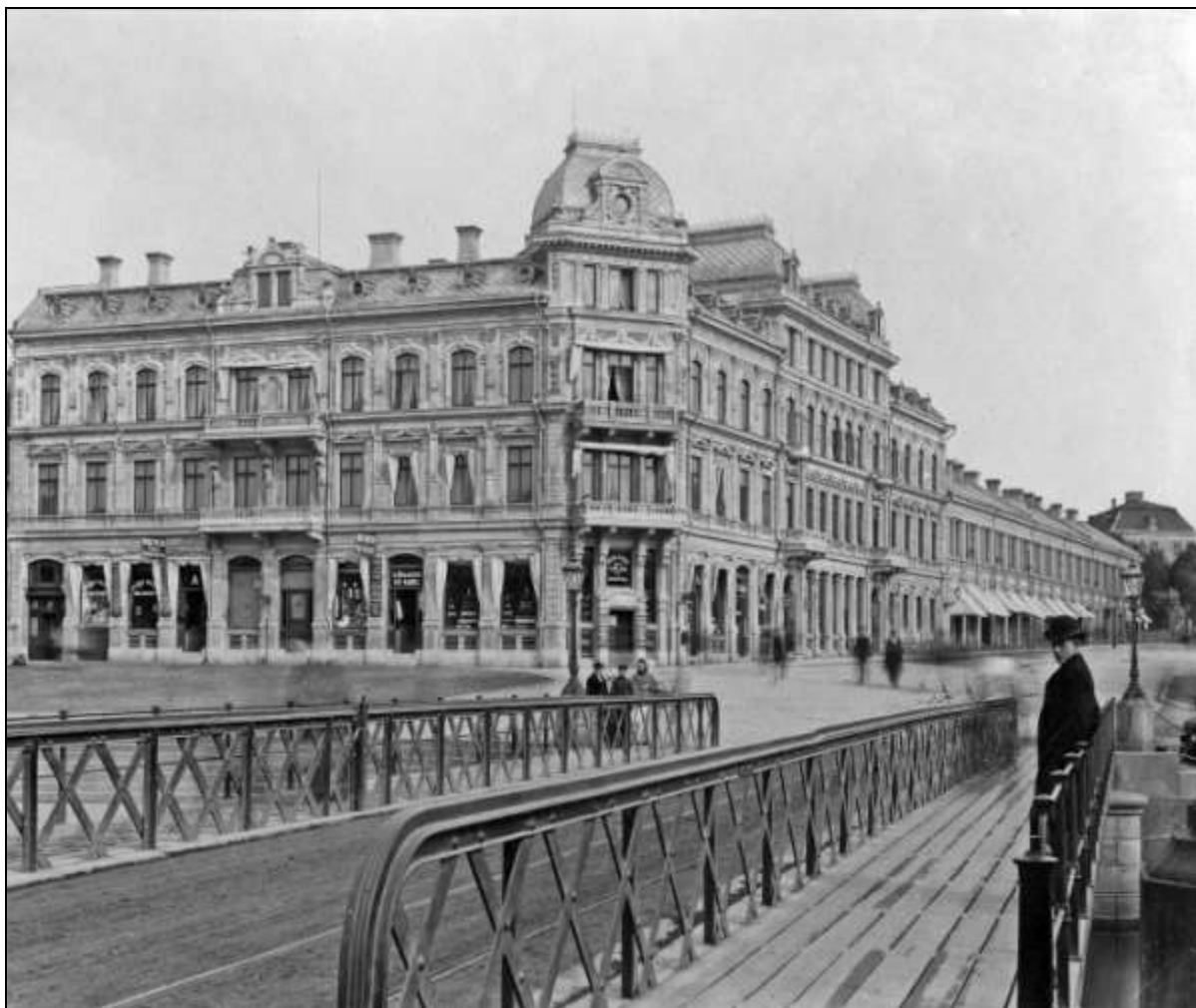
Första Rosenlundsbron sedd från sydöstra landfästet. Brons huvudbalkar med gallerverket framgår tydligt liksom gångbanorna på ömse sidor av balkarna. En estetisk eftergift i balkarnas konstruktion kan vara de vid ändarna nedsvängda överflänsarna. Av speciellt intresse är det spår som är framdraget över bron. Sannolikt är det den smalspåriga (spårvidden var 1 000 mm) hästspårväg som gick mellan Brunnsparken och Slottsskogen och som anlades omkring 1880. Banans sträckning lades om redan 1885 till att gå över den då nybyggda Victoriabron. Spårvägen i Göteborg elektrifierades och lades om 1902. Foto vid okänd tidpunkt. Bild Göteborgs Stadsmuseum.
