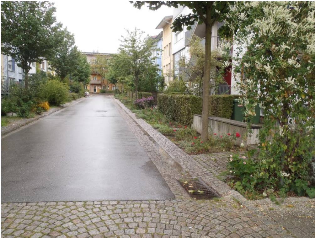
Figur 6. Skålformad ränna i gatsten i Freiburg (Ramböll, 2011)
