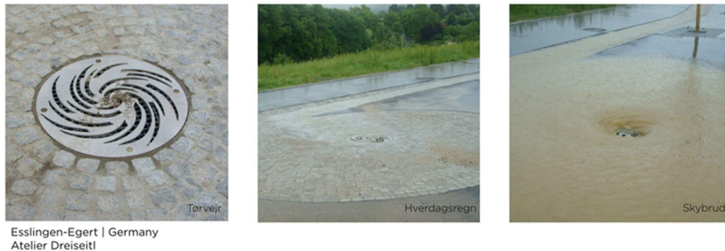
Figur 16. Brunn som gör en virvel för vattnet vid avtappning. Konkretisering af Skybrudsplan for København Vest tog Frederiksberg Vest (Ramböll/Atelier Dreiseitl, 2013)
