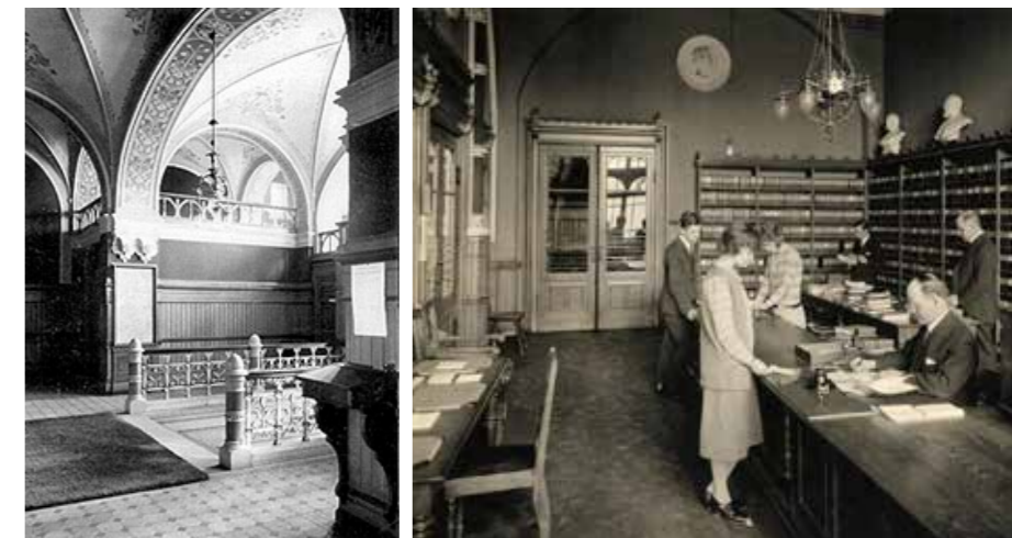
Foto av entréhallen samt expeditjonsdisk 1920-tal (GSM + UB)
