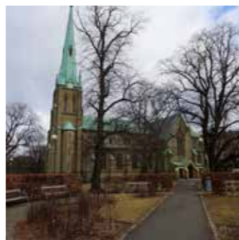
Hagakyrkan Uppförd: 1857-59 Skydd: Byggnadsminne, KML kap 4.
