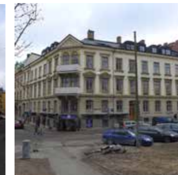
Vasastaden 8:1 (kv Boken) Uppförd: 1870 Skydd: Rivningsförbud och skydds- och varsamhetsbestämmelser i detaljplan.
