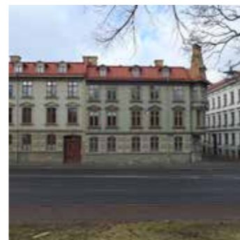
Haga 28:4 (Kv Sabeln) Uppförd: 1886 Skydd: Q (Kulturresevat) i detaljplan. Ingår i bevarandeprog.
