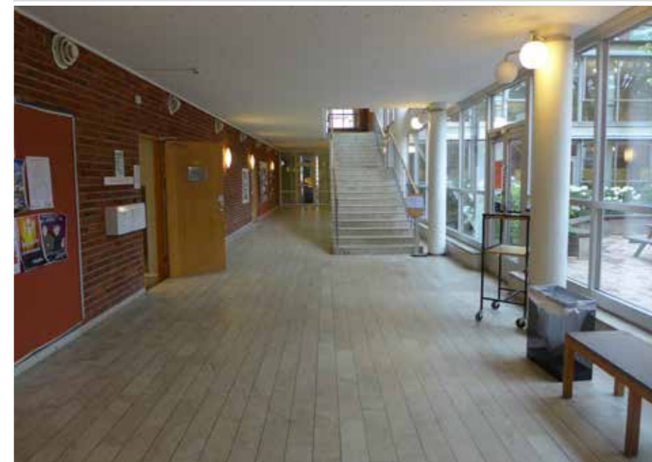
Tidstypisk 1950-talsinteriör i tegellängorna med marmorgolv, trappor, smidesräcken och dörrförlängningar i marmor.
