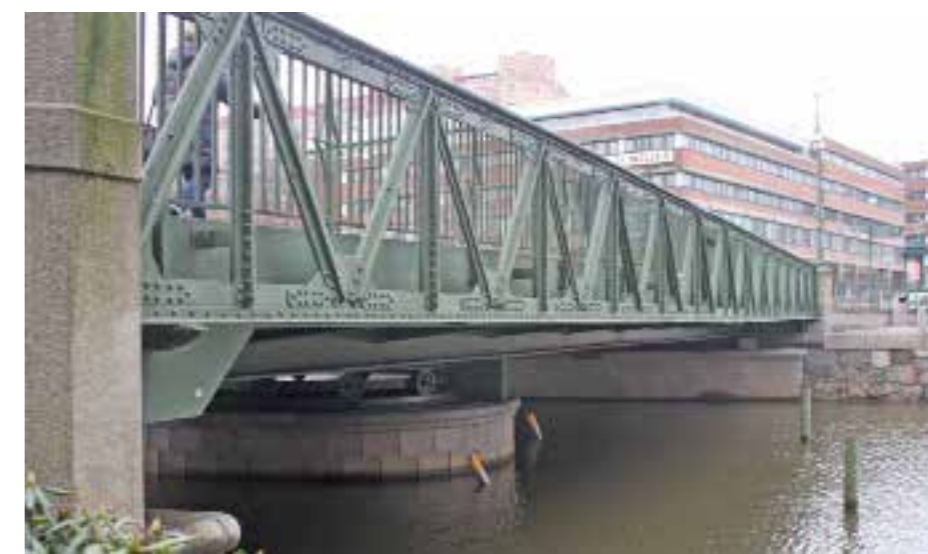
Tredje - nuvarande - Rosenlundsbron. Fackverksbalken har hängts som en "fackverkskuliss" utanför den nya brons bärverk. Av bilden framgår även svängpelarens och landfästernas murverk med ett vulstformat övre skift. Foto Bengt Spade 2014
