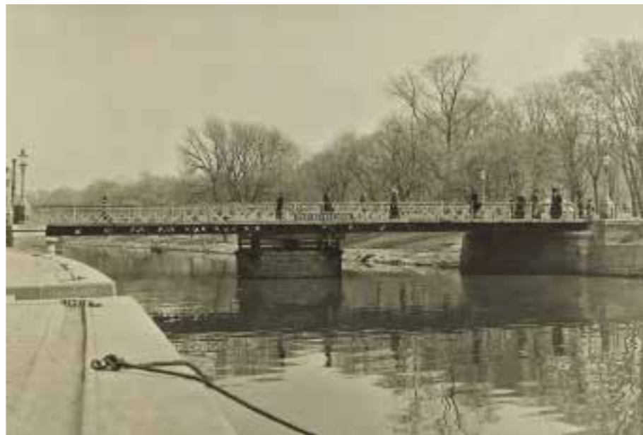
Första Rosenlundsbron omkring 1900. Brons gallerverksbalkar syns tydligt liksom belysningsarmaturerna och murverkens översta, vulstformade skift. Bild i Regionarkivet.
