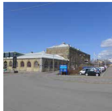
Tull och Packhuset
