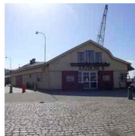
Kajskjul 8 Uppförd: 1885 Skydd: Rivningsförbud och skydds- föreskrifter i detaljplan
