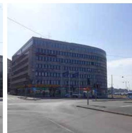
Skeppsbrohuset Uppförd: 1935 och 1967 Skydd: Ingår i bevarandeprogrammet
