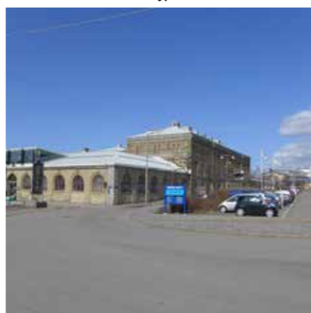
F d Tull- och Packhuset Uppförd: 1864 Skydd: Rivningsförbud och skydds- föreskrifter i detaljplan
