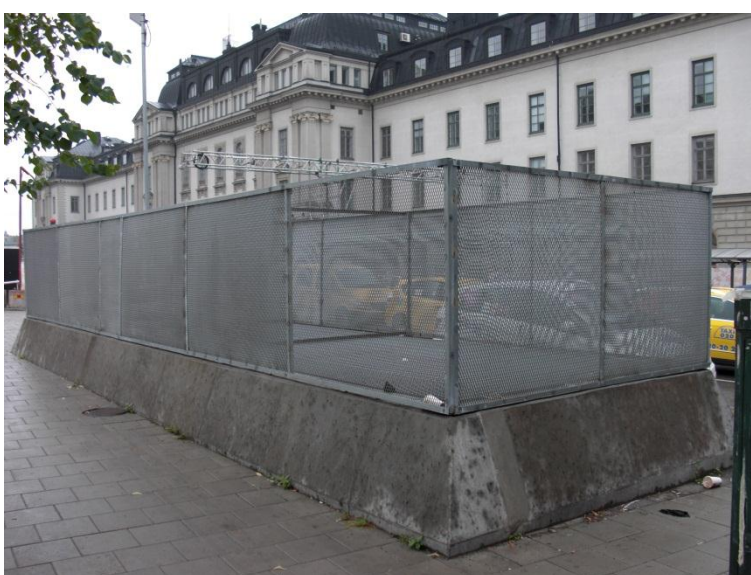
Samma som ovan: Schaktet har ett tillfälligt galler på bilderna.
