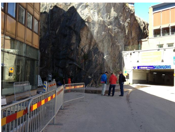
Ingång till A2 - arbetstunnel Rosenlund.
