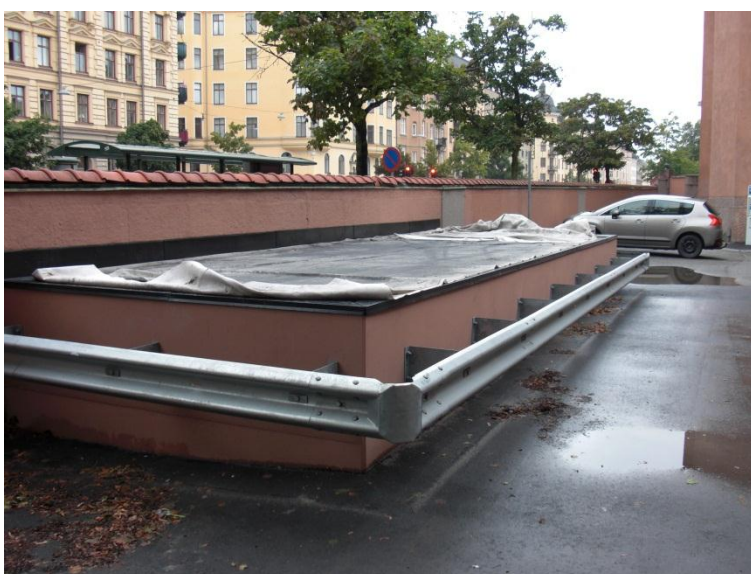
Exempel från Citybanan. Brandgas- och tryckutjämningsschakt vid Odenplan finns vid en parkeringsplats vid Vasa real.
