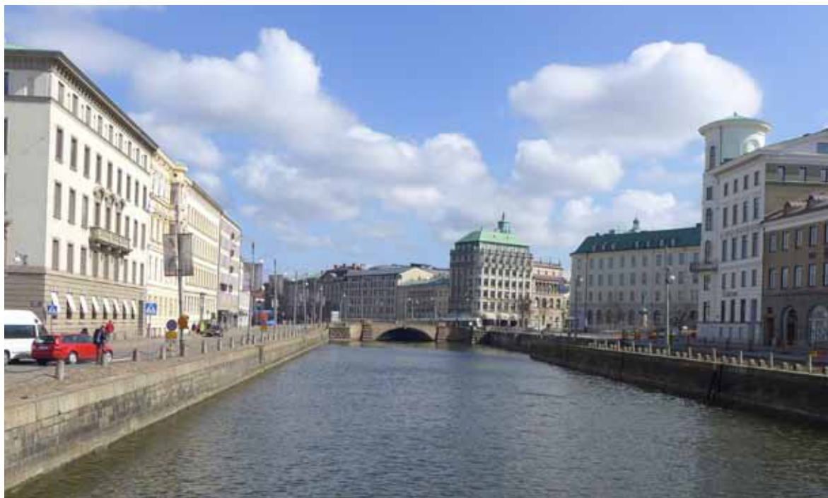
Figur 6.2:1 Stora Hamnkanalen ger en representativ bild av Göteborg som befäst handelsstad, residens- och sjöfartsstad. Den holländska kanalstadsplanen är också en del av riksintressets uttryckta värden. (Foto: Antiquum AB)
