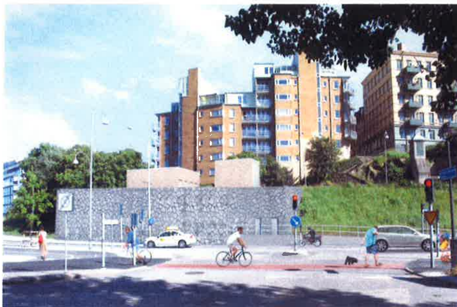
Serviceschakt Sankt Eriksgatan på Kvarnbergets nordvästra sida.
