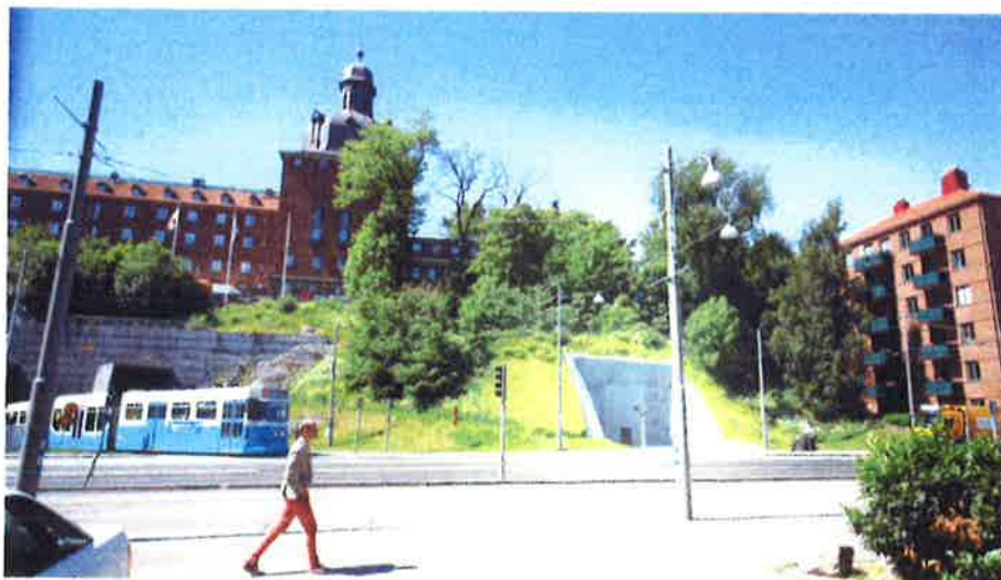
Servicetunnel- mynning vid Carlanderska
