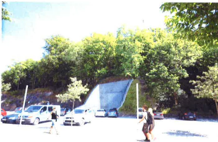
Servicetunnel- mynning vid Liseberg
