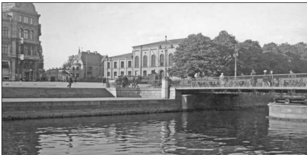
Norra delen av andra Rosenlundsbron på ett foto som med tanke på klädmotet kan vara taget under senare delen av 1920-talet. Av bilden framgår nordvästra landfästets svängda vingmur med ett kantigt krönskift, landfästespallens och svängpelarens ålderdomliga murverk med utkragade och vulstformade övre murskift samt stenarnas fasade kanter, kandelabrarnas utformning med fundament av sten samt det påfallande modernt utformade räcket för gångbanan. Bild Göteborgs Stadsmuseum.
