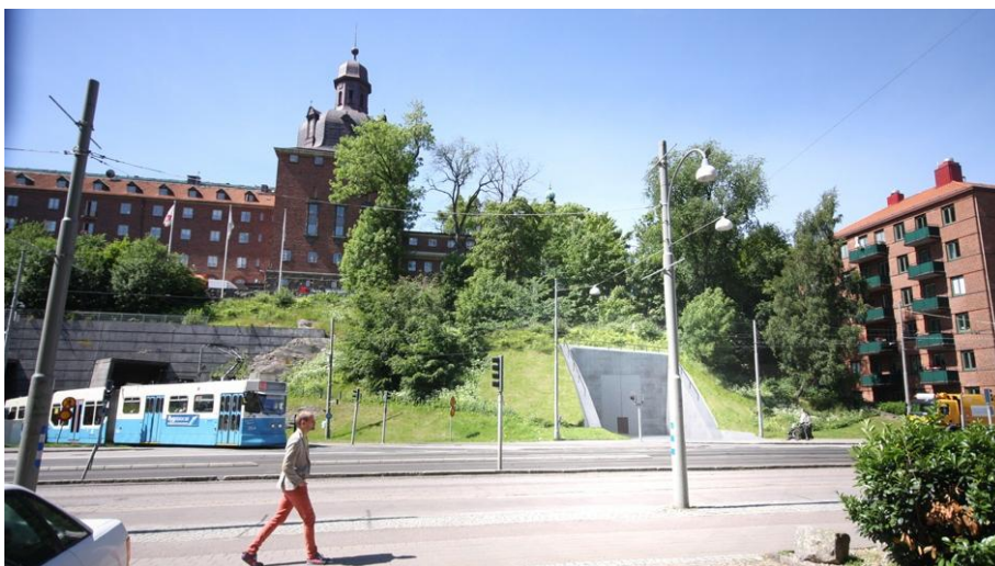
Servicetunnel- mynning vid Carlanderska
