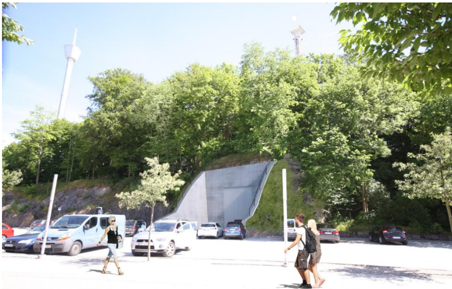
Servicetunnel- mynning vid Liseberg
