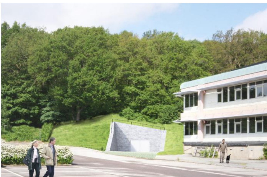
Servicetunnel- mynning vid Sankt Sigfridsgatan
