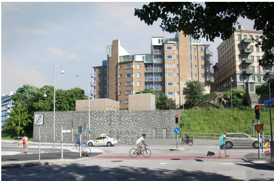
Serviceschakt Sankt Eriksgatan på Kvarnbergets nordvästra sida.
