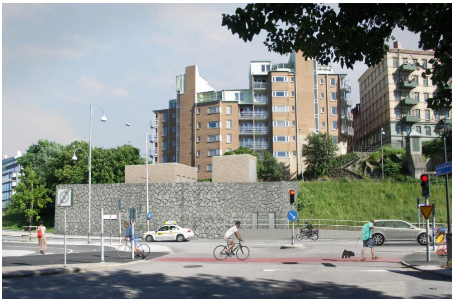
Serviceschakt Sankt Eriksgatan på Kvarnbergets nordvästra sida.
