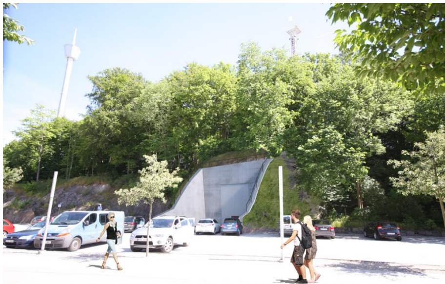
Servicetunnel- mynning vid Liseberg
