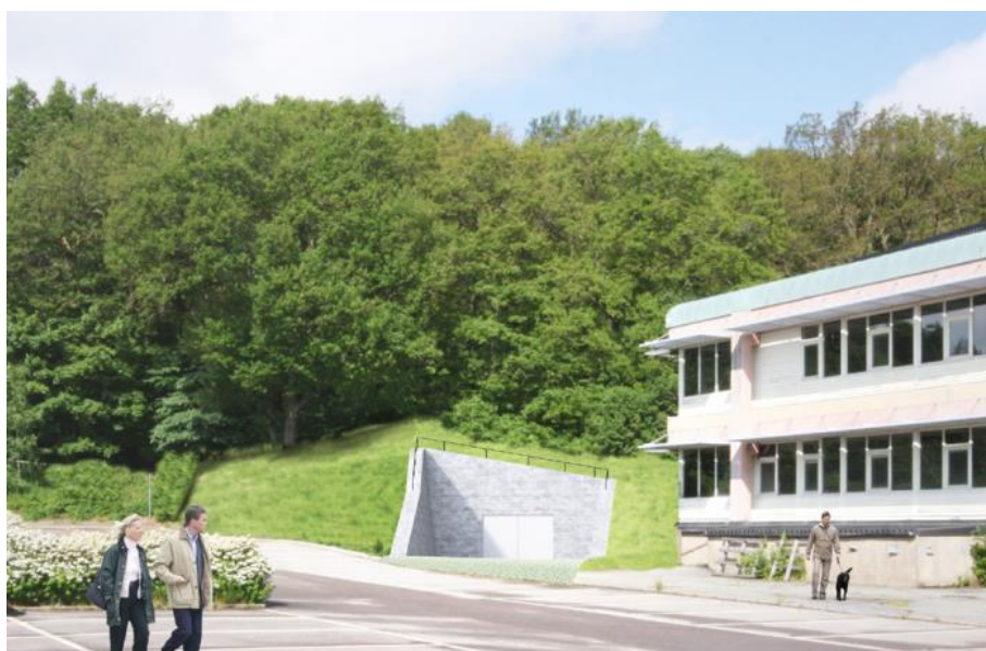
Servicetunnel- mynning vid Sankt Sigfridsgatan
