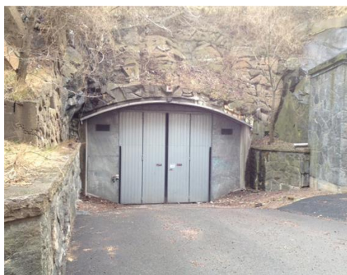
Befintlig ingång Kvarnberget
