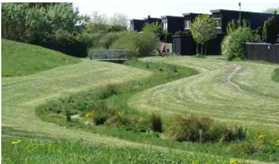
Bild 6: Svackdiken i Fjärilsparken, Malmö. Källa: VA SYD.
