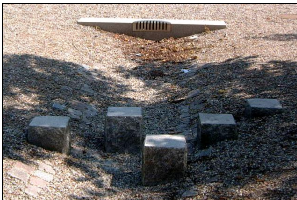
Figur 11. Torr översvämningssyta med modern gallerbrunn, exempel från Norra hamnen, Helsingborg
