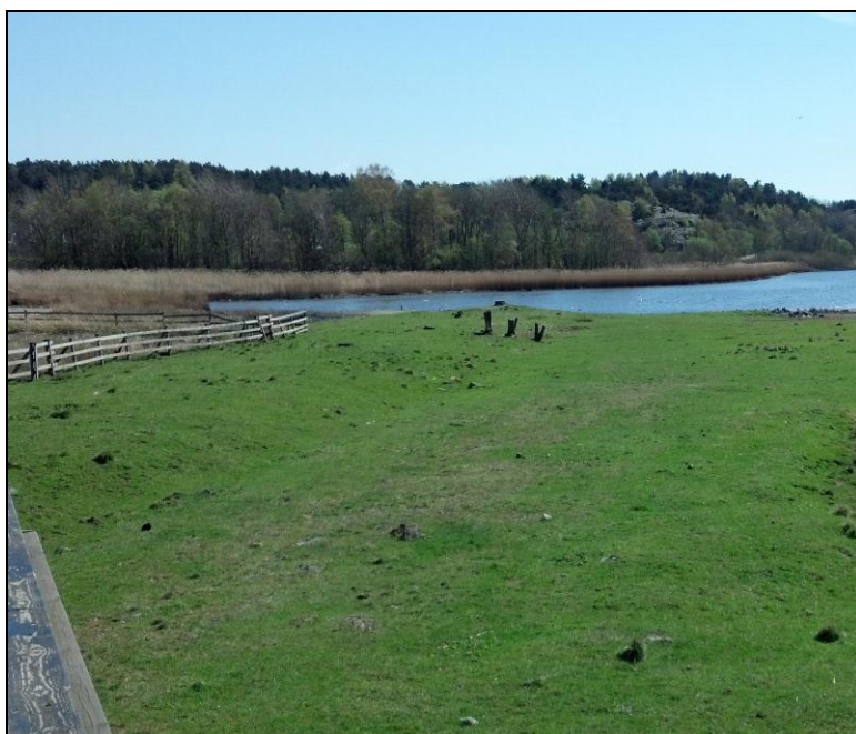
Figur 2. Dagvattenutlopp till Välen från ledning med dimensionen 1600 mm. Ledningssträckningen kan skönjas som en upphöjning av marken till vänster i bild
