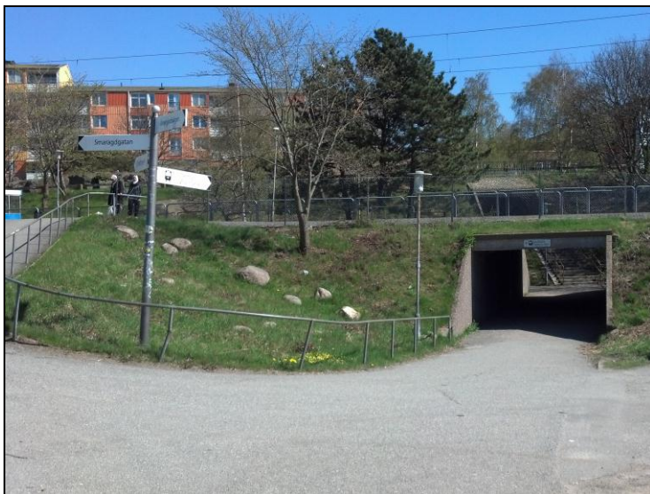
Figur 6. Viadukt under spårvagnsspår vid Smaragdgatans hållplats
