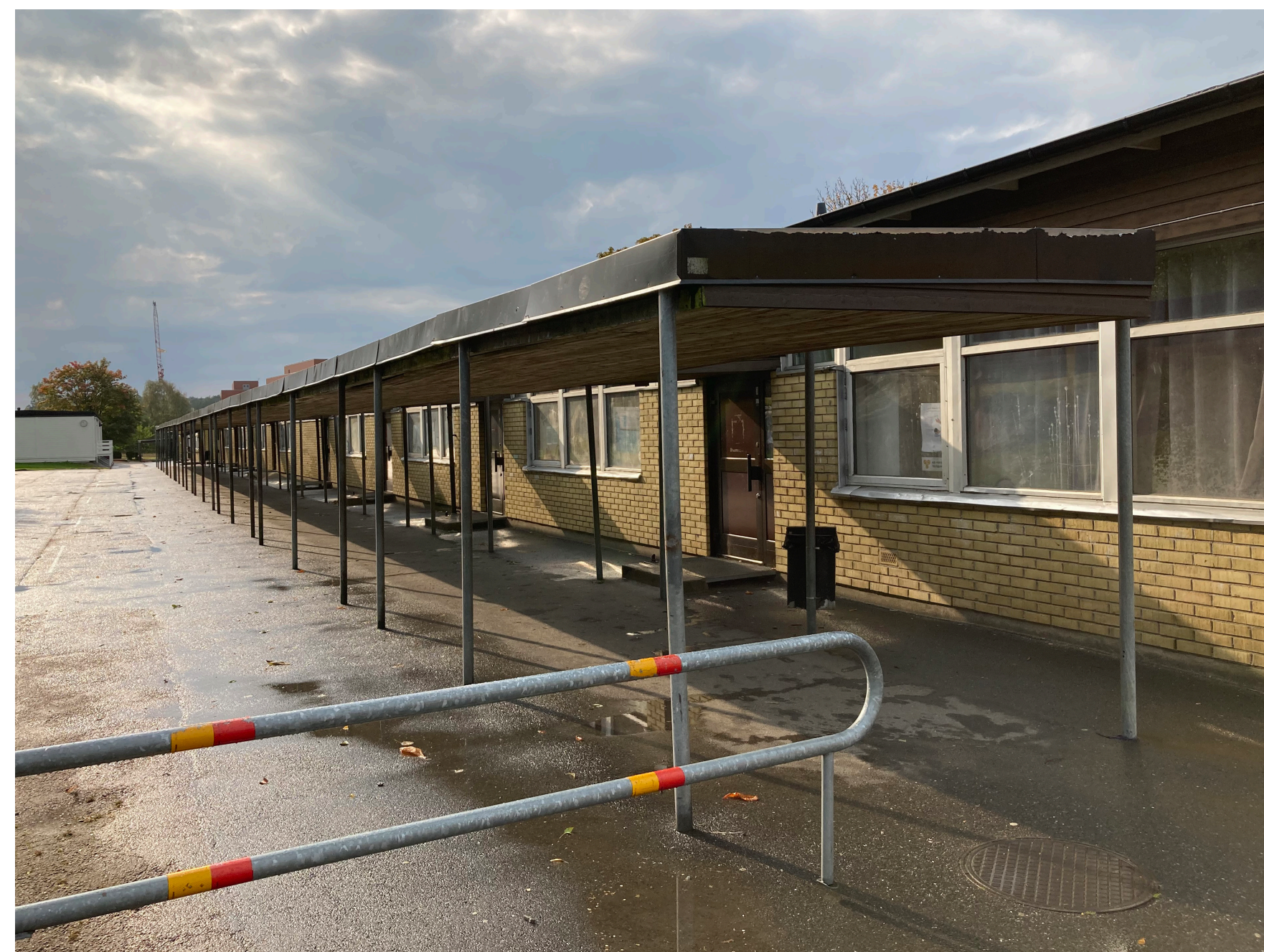
Befintlig skola. Foto: Karin Fäldner stadsbyggnadskontoret
