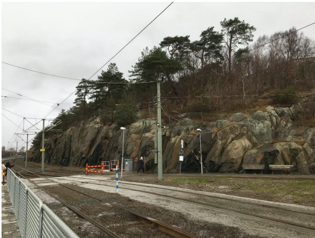
Figur 4. Planområdet sett från söder. Bergskärning mot spårvägen.
