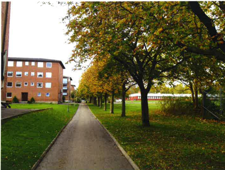
Kastanjeallén sedd från söder med befintliga skolbyggnader inom planområdet till höger och u-formade lamellhus i fyra våningar med halvt öppna gårdar till vänster.
