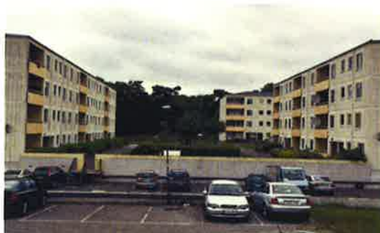
Gårdsrum mellan befintlig byggnation och parkering mot Brilljant-gatan.
