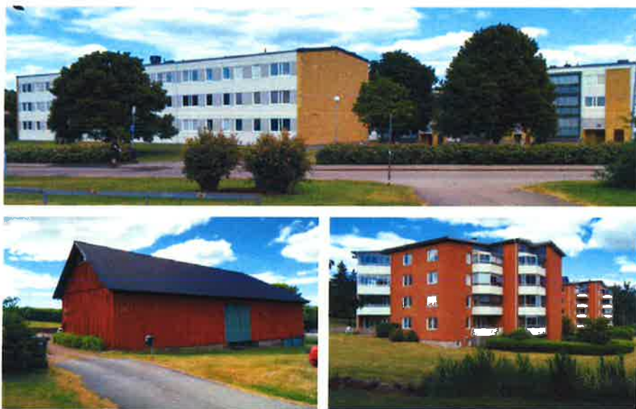
Bebyggelse i direkt anslutning till planområdet. Överst: Lamellhus från 70-talet, öster om området. Nere till vänster: Ladugård i sydväst. Nere till höger: Byggnader från 90-talet, direkt norr om planområdet.
