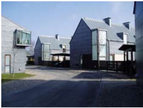
Radhusbebyggelse i Viken, Helsingborg. Exempel på en fin bostadsgata med gröna passager mellan husen.
