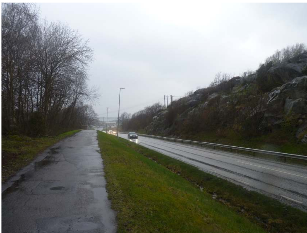
Den västra sträckan som bedöms vara lämplig för anläggning av ledarmar och passager.
