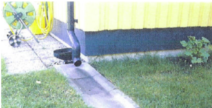
Bild 9: Exempel på stuprörsutkastare för avledning av takvatten till infiltration på gräsmatta. Foto: Mathias de Maré.
