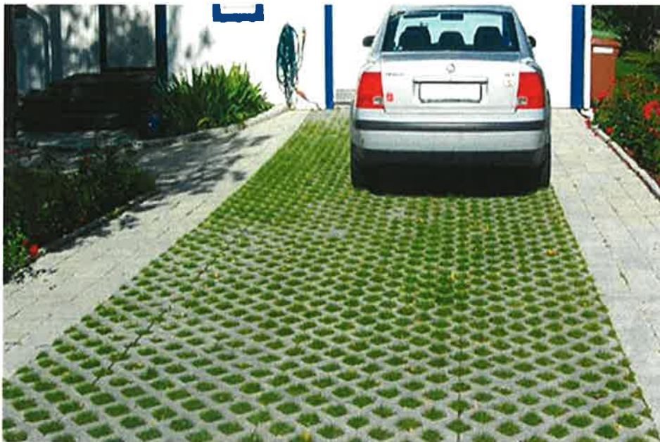
Gräsarmering på garageuppfart. Källa: www.alltimark.se
