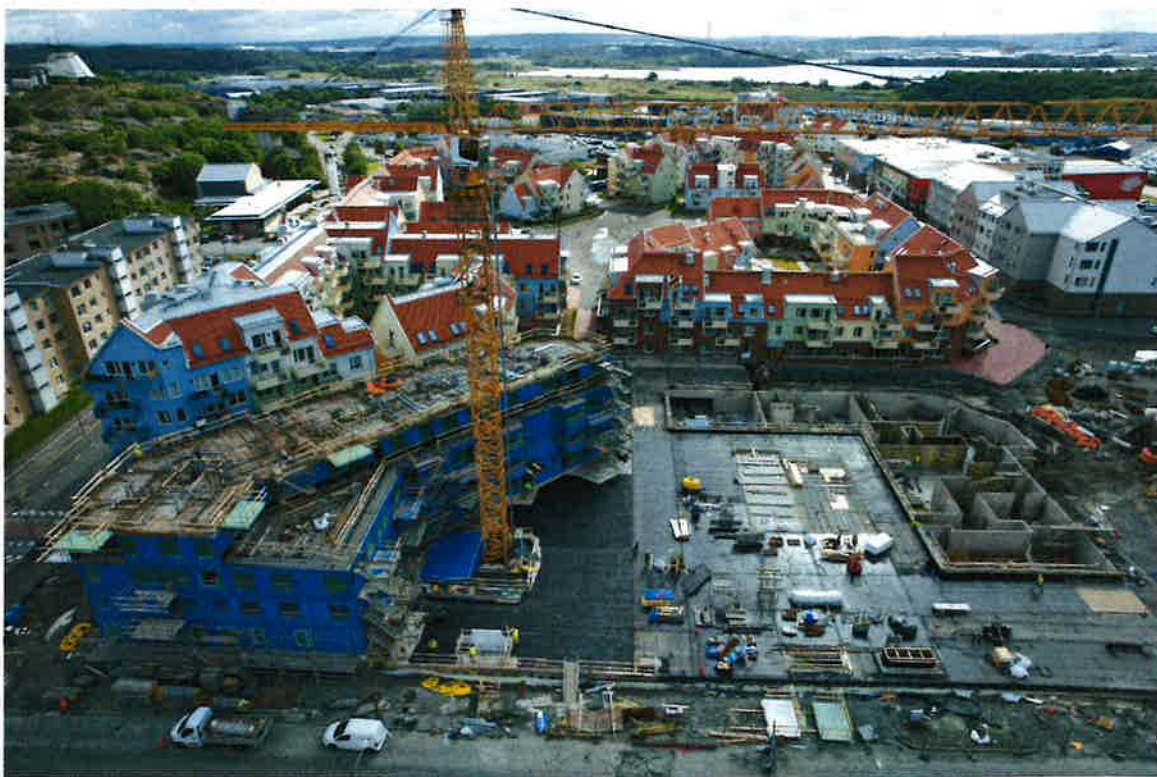
Figur 4: Foto över pågående byggnation inom planområdet (Amhult 2, 2024)
