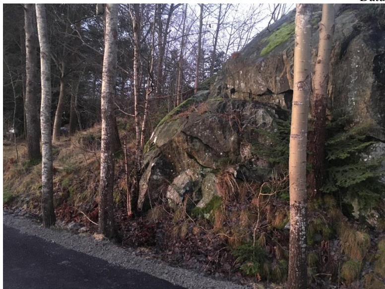
Foto 2. Bergets södra sida utgörs av en brant bergskärning
