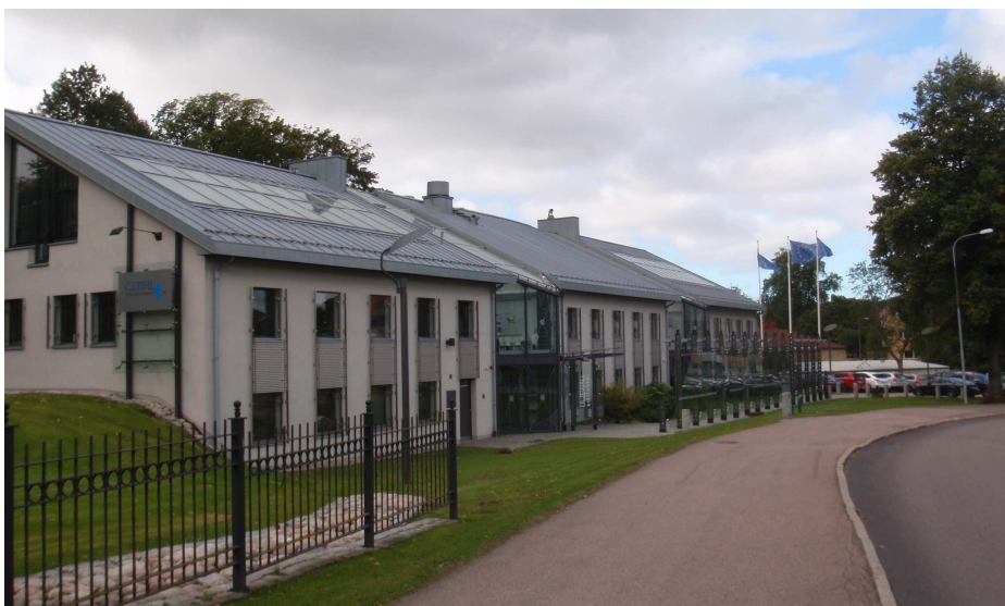
Kontorshus på Torp 47:3 ut mot Töpelsgatan
