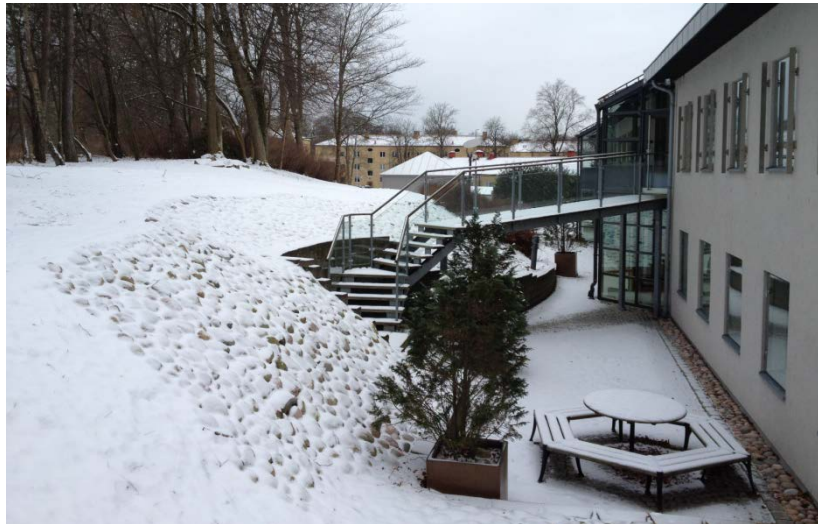
Foto 2. Baksidan av befintligt kontorshus där det planeras tillbyggnader in i slänten.
