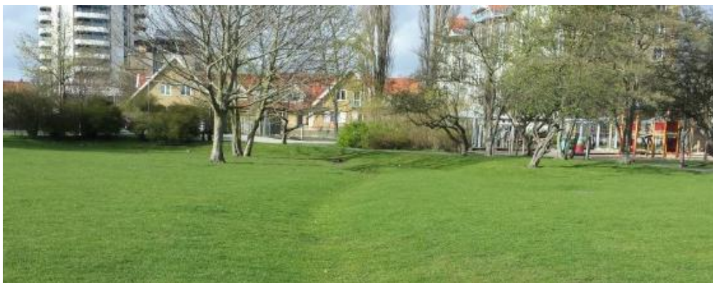
Figur 18. Exempelbild på ett mjukt skålat avskärningsdike/svackdike med flacka slänter. Källa: Ramböll
