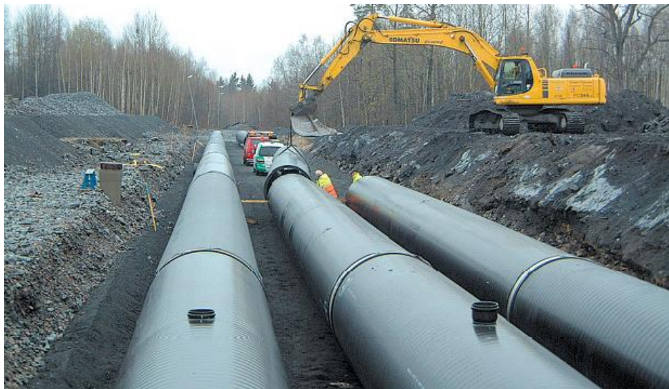
Figur 13. Exempelbild på dagvattenmagasin av plast. Fotot visar Weholite dubbelväggiga lättviktsrör i polyeten. Källa: www.kwhpipe.se
