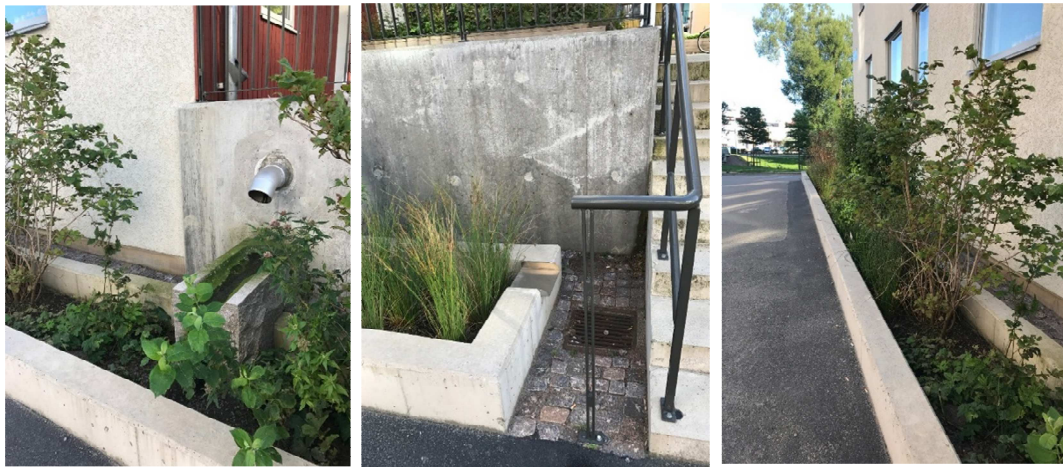
Figur 11. Öppen dagvattenhantering i anslutning till husfasad, Kvillebäcken. Foto Olof Persson
