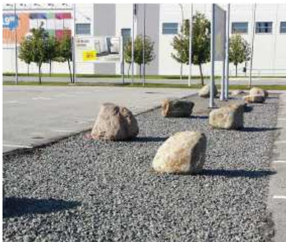
Figur 13. Krossdike i parkering
