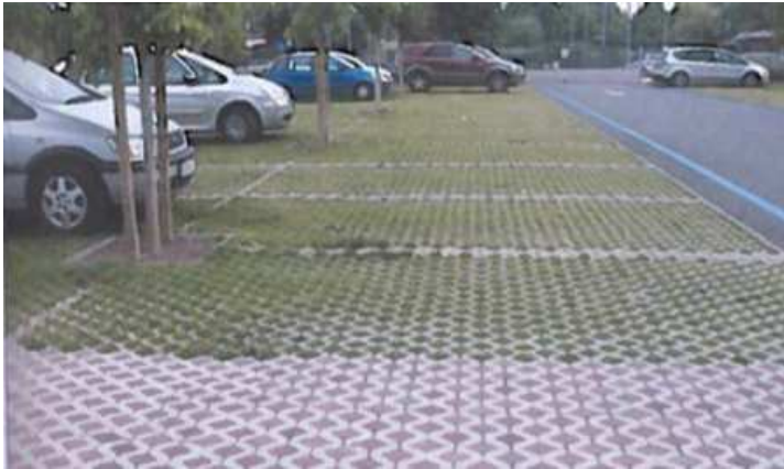
Figur 14. Parkeringsyta försedd med en gräsförsedd rasteryta samt ett markerat gångstråk utan gräs. Rasterytan är av betong. Bild från Svenskt vattens publikation P105.
