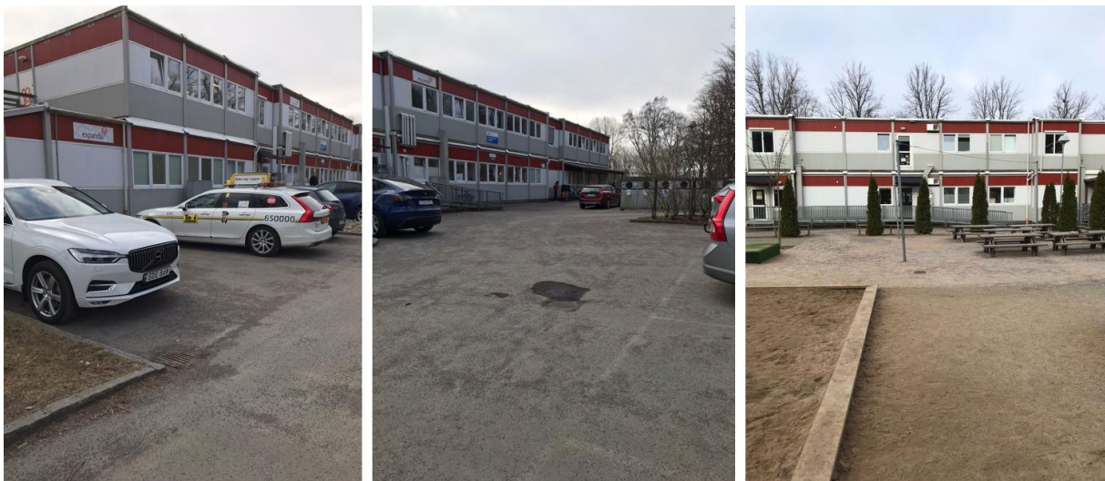
Figur 5 Rännstensbrunnar inom parkeringsplatsen och skolgården. (Foto: Sofia Polo).
