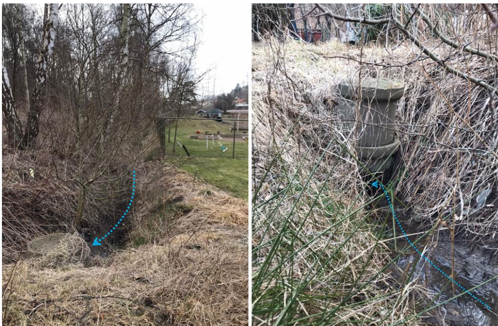
Figur 4 Till vänster: Diket. Bilden taget mot söder. Till höger: Dikets utlopp som kopplas till kombinerat systemet längs Bäckuddsgatan. Bilden taget mot norr (Foto: Sofia Polo).
