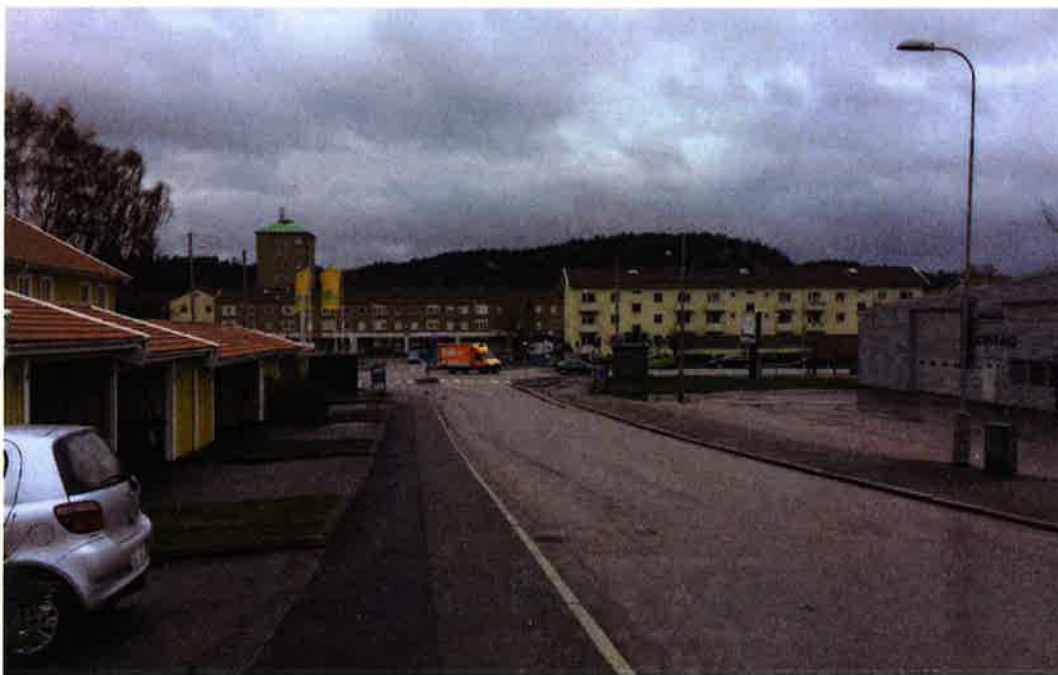
Vy över Klövervallsgatan mot norr med den numera rivna verksamhetsbyggnaden till höger i bild, april 2016.
