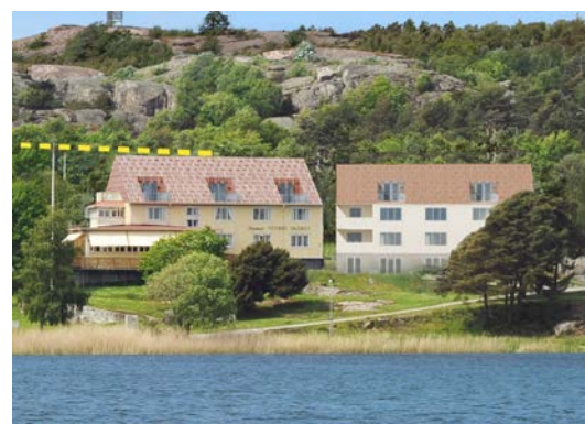
Pensionat Skäret med höjt tak samt ny byggnadskropp till höger.
