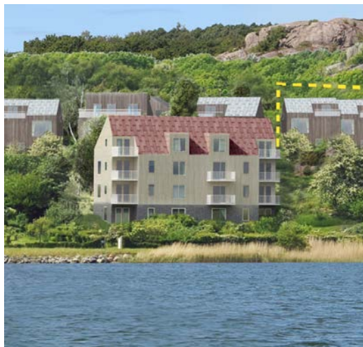
Ny byggnad som ersätter Äppelbo, i bakgrunden syns grupphusbebyggelsen i område 2.
