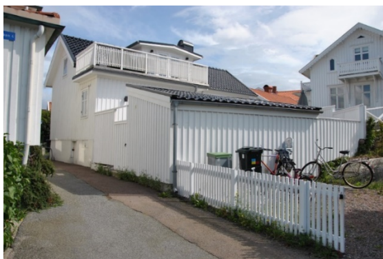
Figur 16: Tak belagt med svart plåt. Täta höga plank har tillfogats.
