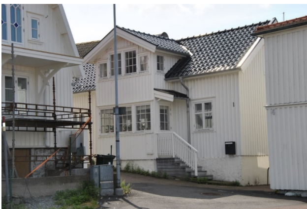
Figur 4: Vy från Styrö Tångenväg, bostadshuset nordost.
