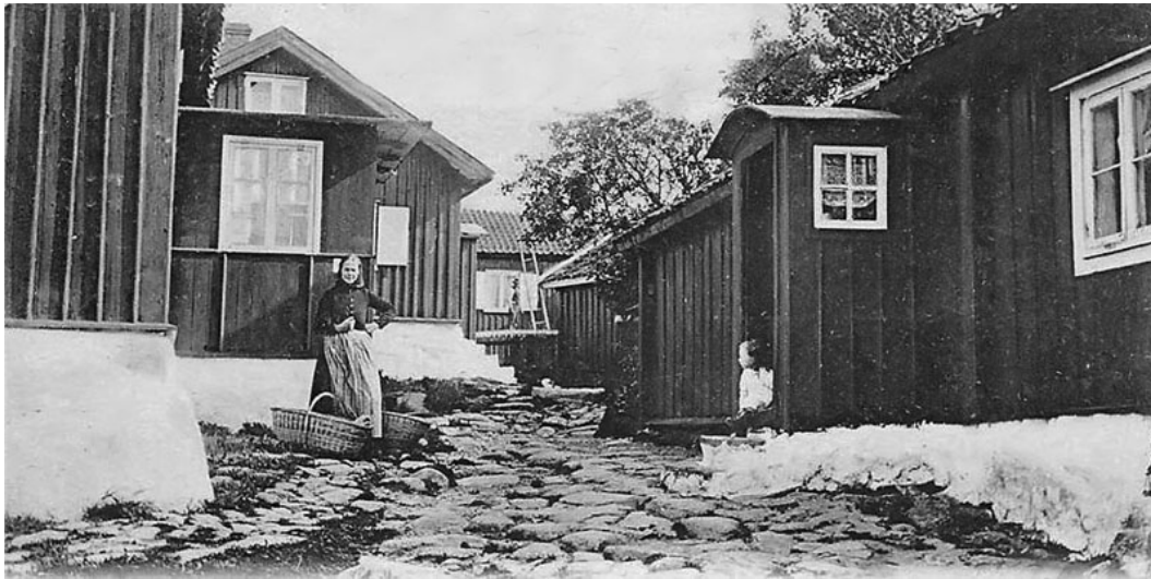
Figur 14: Styrso Tångenväg, "nya" bostadshuset från sekelskiftet 1800-1900.
