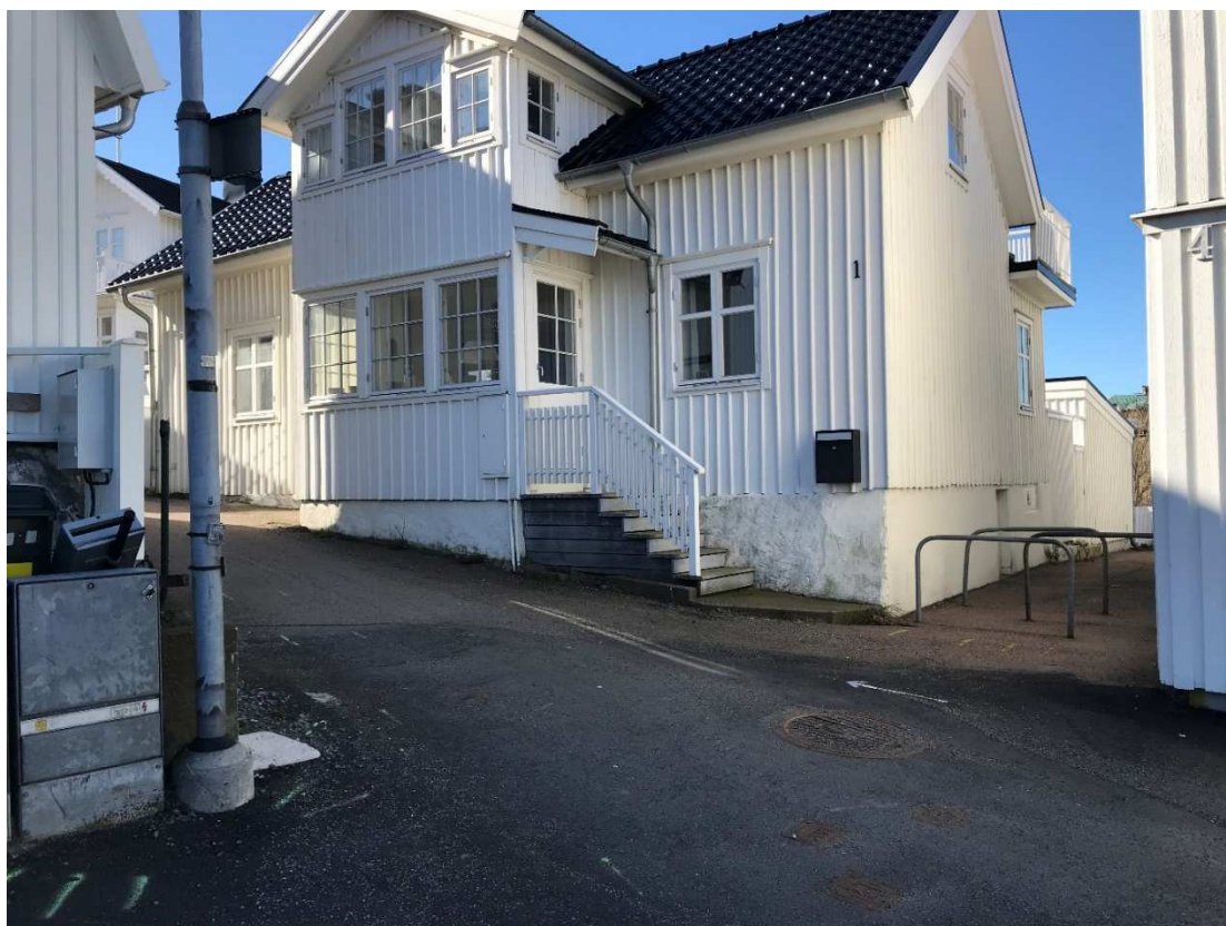
Figur 1. Planområdet med befintlig byggnad sett från nordost, dvs fastigheten Styrso 3:159.
