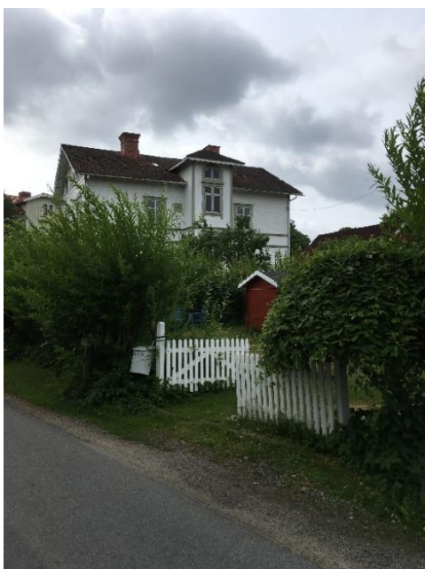
Byggnad öster om planområdet
