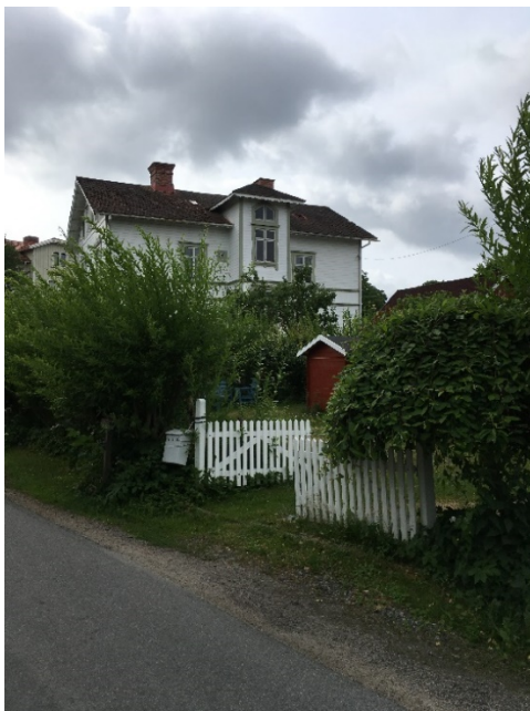
Byggnad öster om planområdet
